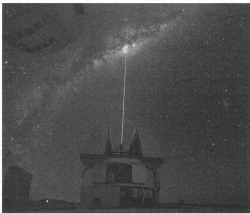
Abb. 340: Das Paranal -Observatorium in der Atacama-Wüste im nördlichen Chile. Zur Beobachtung des Zentrums der Milchstraße wird mithilfe eines Lasers ein künstlicher Leitstern erzeugt. Dieser ermöglicht eine Korrektur der Luftunruhe durch adaptive Optik und dies auch an Stellen, wo kein heller natürlicher Leitstern vorhanden ist. (Wikipedia)
